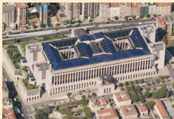
Portugals största bank, Caixa Geral de Depósitos i Lissabon, anses ha världens största installation av soldriven kyla i kontorsbyggnad.
